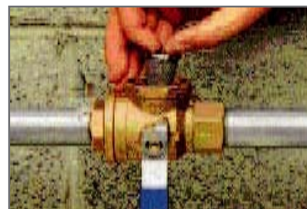
3. Demonter låsering og ta ut filter
