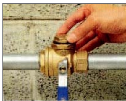
5. Monter filter og låsering, skru så til pluggen
